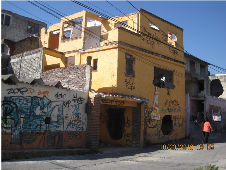
Casas en proceso de ser demolidas como parte de la construcción de la Supervía.
